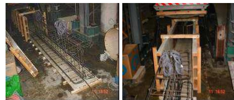
Figura 1. Moldes y armadura de las vigas de HC y HAC-RM
