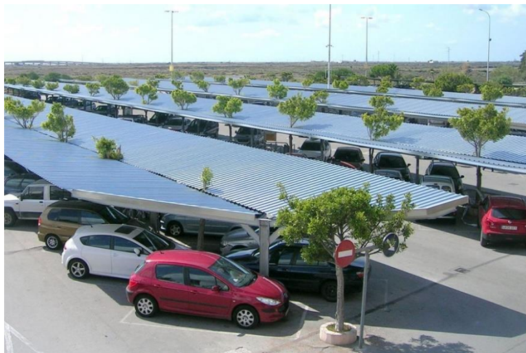
Figura 34. Pàrquing solar per carregar els acumuladors [34]
