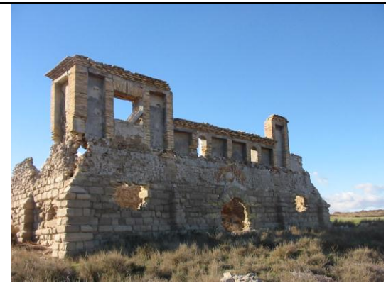
FOTOGRAFÍA 14 Otro aspecto del conjunto de los edificios
