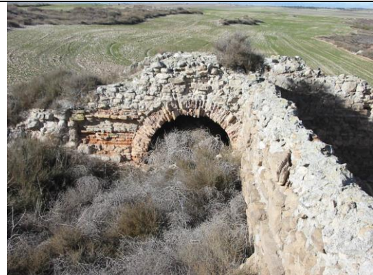
FOTOGRAFÍA 12 Restos de los edificios
