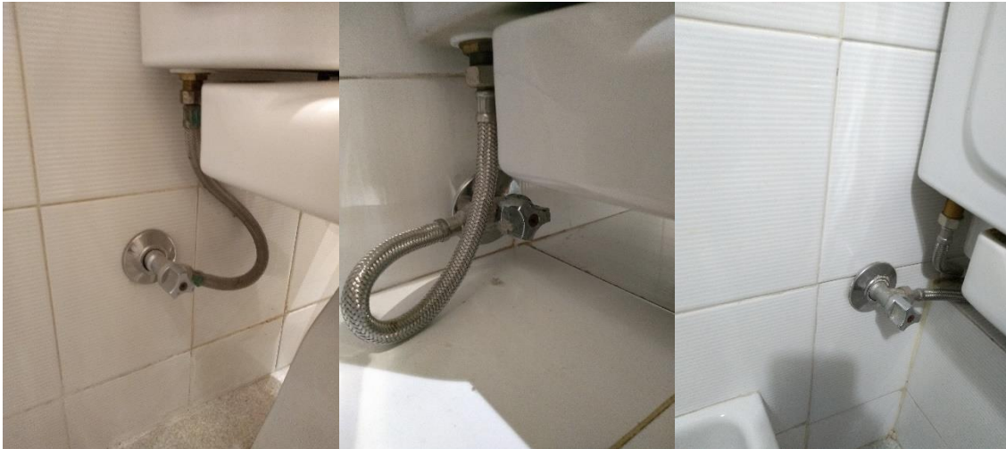
Il·lustració 30: Claus de pas dels diferents vàters. (Font: Elaboració pròpia)
