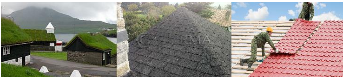
Il·lustració 2: Sostre verd, asfàltic i metàl·lic, d'esquerra a dreta. (Font: Google Images)
