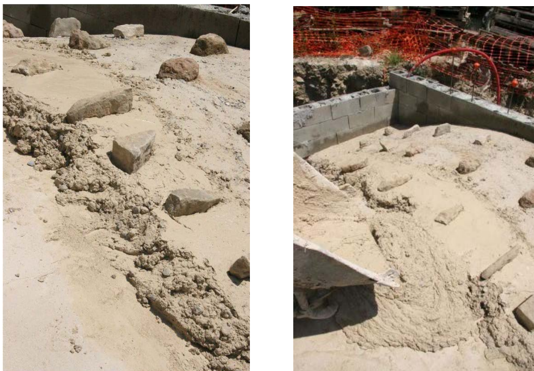
Figura 7. Dos fotografías de Oriol Roselló que muestran el proceso de hormigonado por tongadas y los conectores de piedra, de la vóveda.
