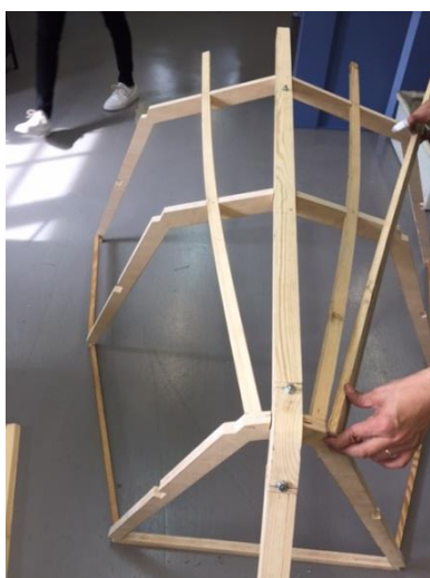
Figura 100. Colocación de los refuerzos
