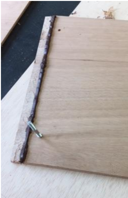
Figura 112. Tira de Sikaflex® en la unión transversal
