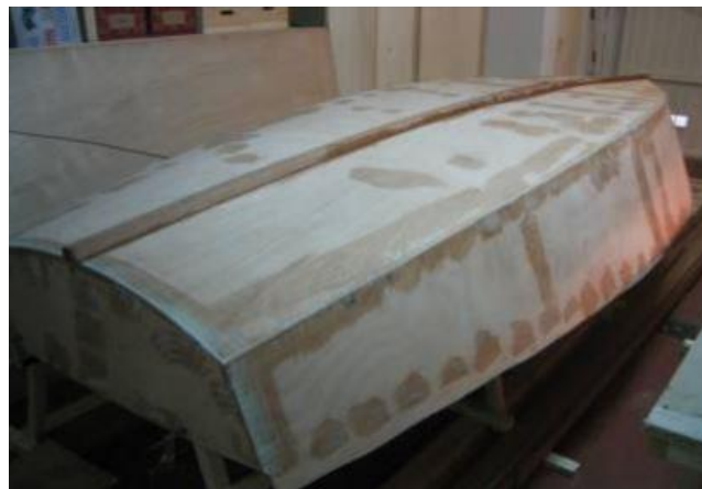
Figura 7. Forro de contrachapado
