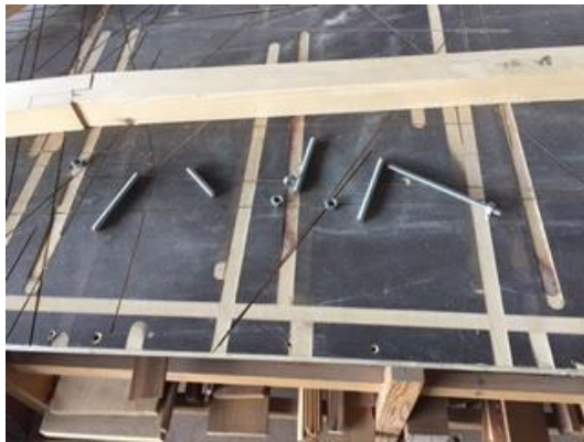
Figura 96. Tornillos de unión de la quilla
