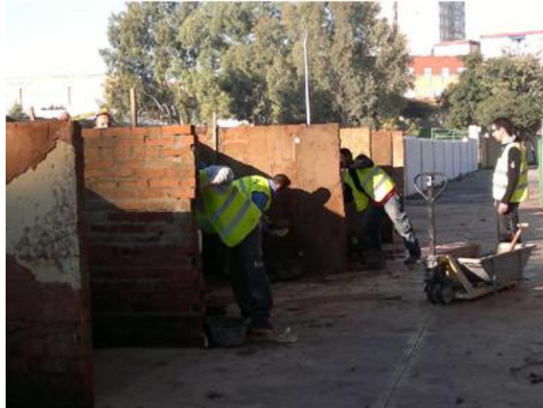
Figura 16: Clase práctica de revestimientos continuos en el IES La Rosaleda (49)
