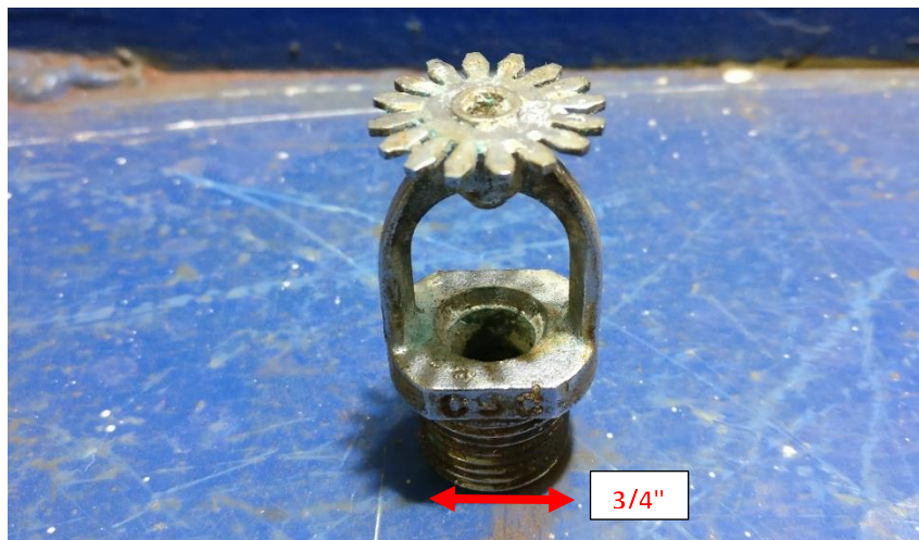
Ilustración 34. Rociador Drencher. Fuente propia.
