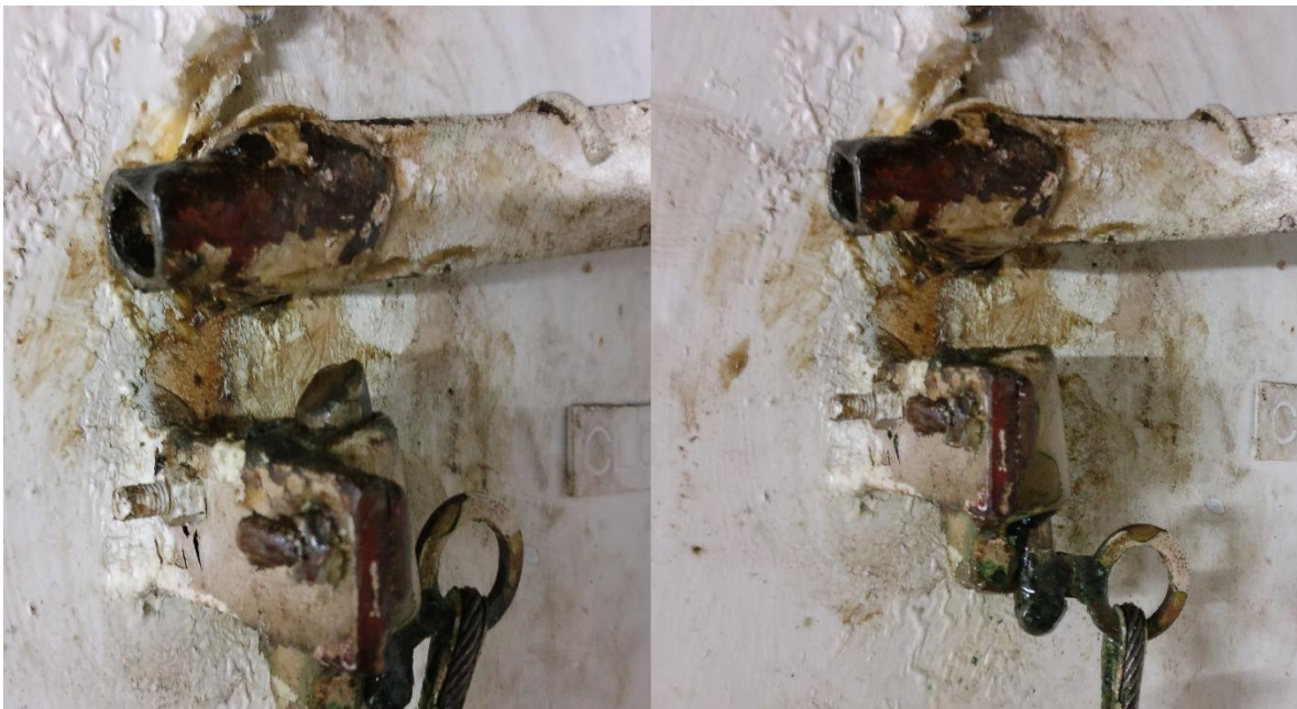
Ilustración 64. Seguro del eje sin tirar del cable (izqda.); Tirando del cable (drcha.) (Al usar el tirador situado en el exterior del local, el eje queda liberado y se cierra gracias al muelle interno). Fuente propia.
