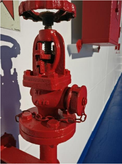
Ilustración 20. Hidrante UNI45. Fuente propia.
