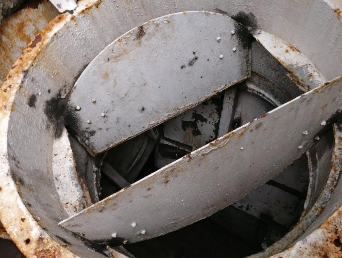
Il·lustració 54. Uno de los dampers de la imagen anterior, visto desde dentro de su casetón. Fuente propia.
