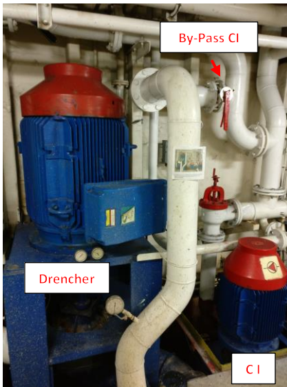
Ilustración 33. Bomba Drencher. Fuente propia.
