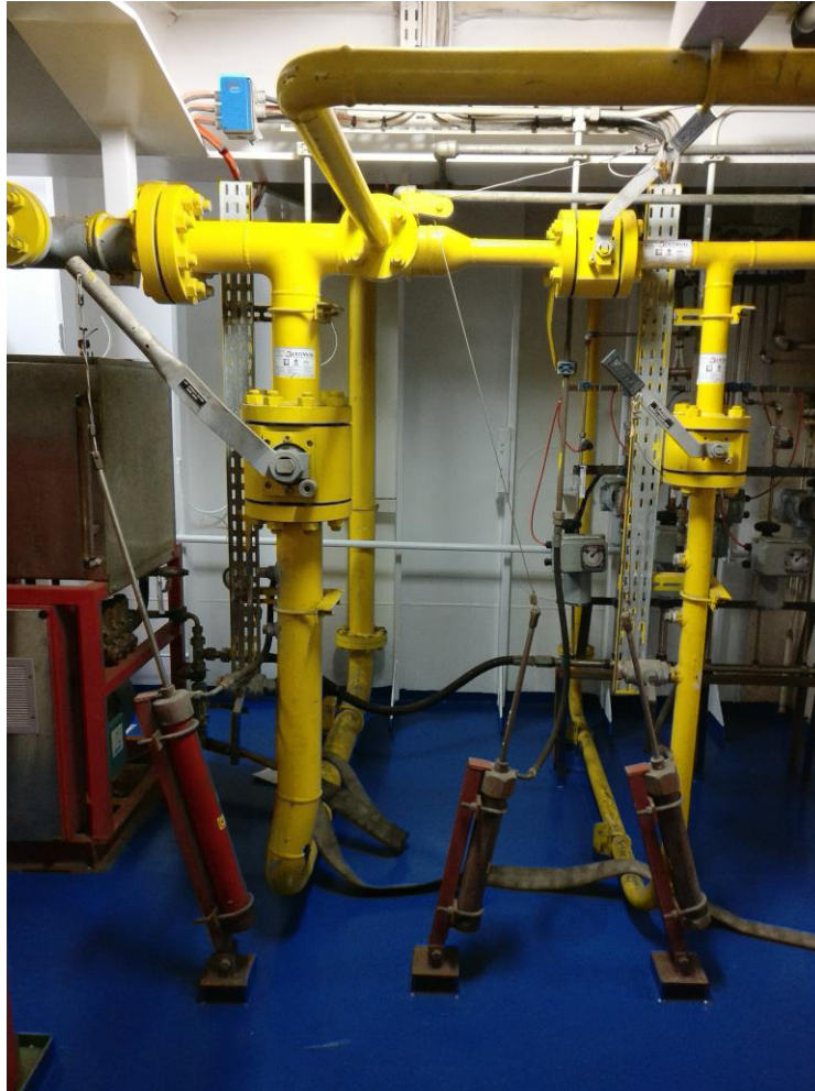
Ilustración 42. Los cilindros de disparo accionan los pistones, los cuales abren las válvulas. Fuente propia.
