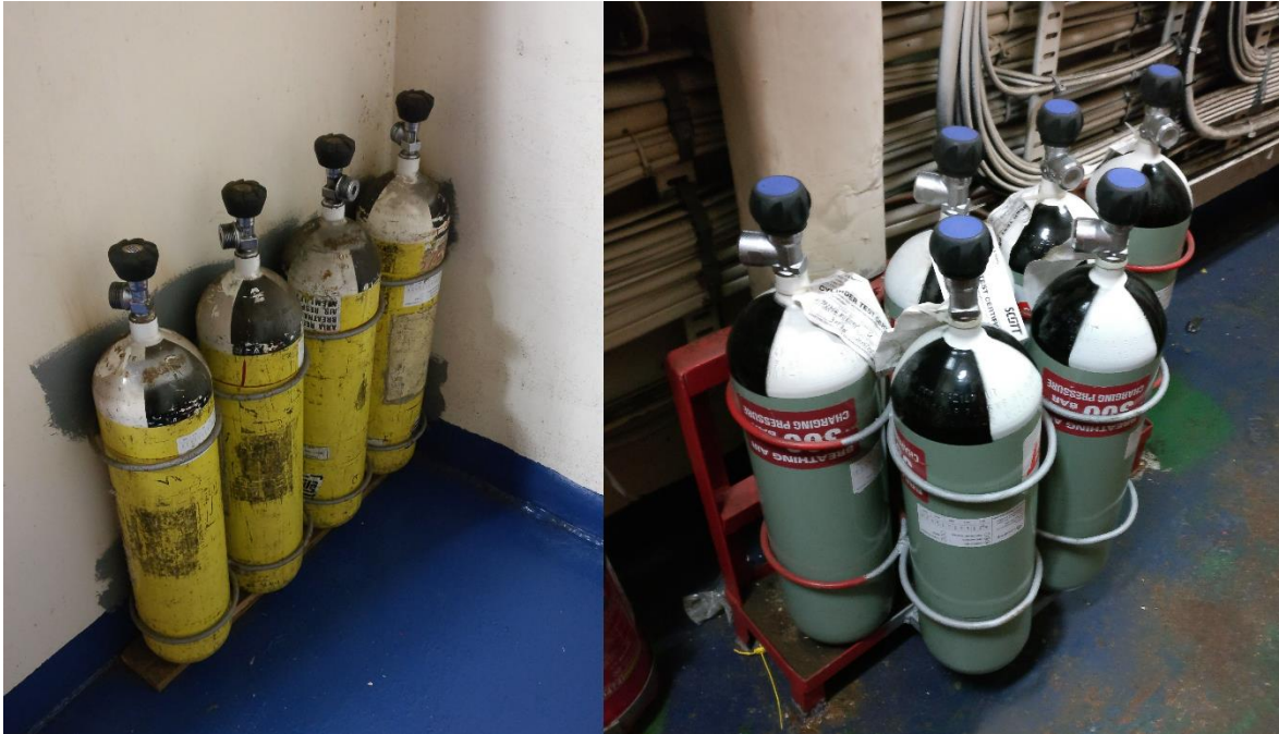
Ilustración 52. Botellas Spaciani (izqda.) y botellas Scott (drcha) estibadas en Fire Stations. Fuente propia.
