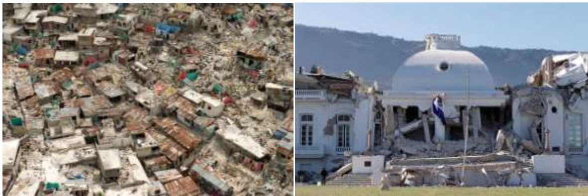
Figura 1 Impactes a les infraestructures del centre de Port-au-Prince 4 (esquerra) i edifici presidencial 5 (a la dreta).
