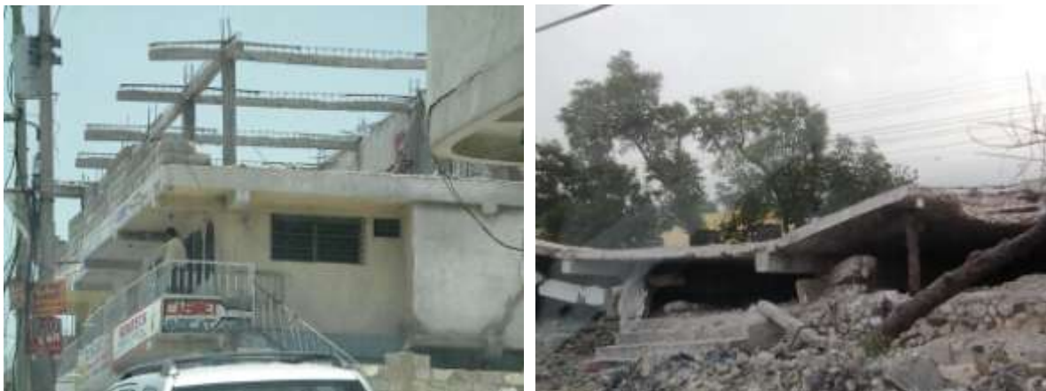
Figura 5 A l'esquerra: les lloses de formigó pesades abastaven espais oberts de més de tres metres. A la dreta: el pes de les lloses va fer que els edificis s'enfonsessin com una torre de cartes. Font: Audefroy, 2011.
