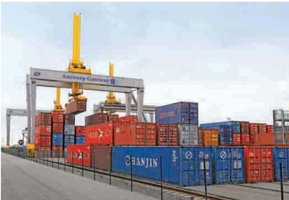
Imagen 4. Grúa apiladora automatizada en el puerto de Amberes (Bélgica)
