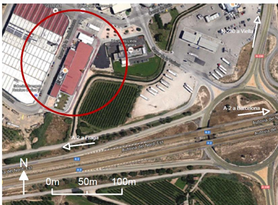
Figura 72. Emplaçament del cas pràctic d'aplicació, local comercial "bonÀrea" de Torrefarrera. Font pròpia.
