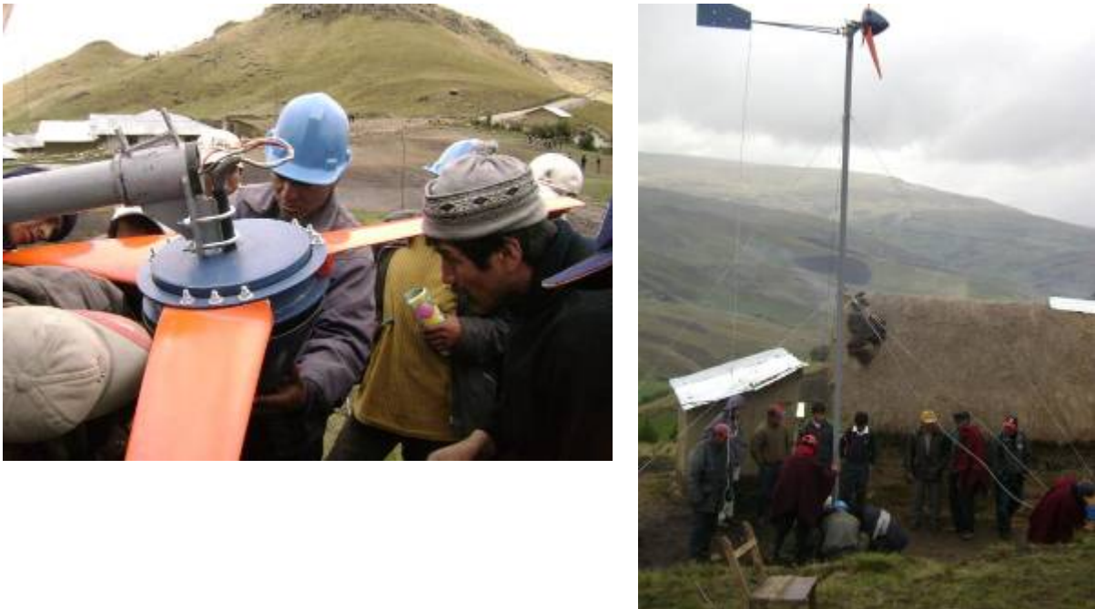
Figura 8. Imatges de la fase de instal·lació dels aerogeneradors a la comunitat de El Alumbre.
