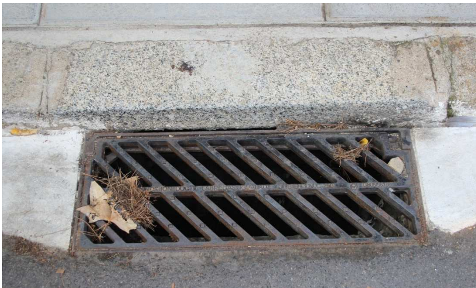
Figura 37: Rejas utilizadas a lo largo de la calle. Ubicaciones en la Figura 36 . (Fuente: propia)
