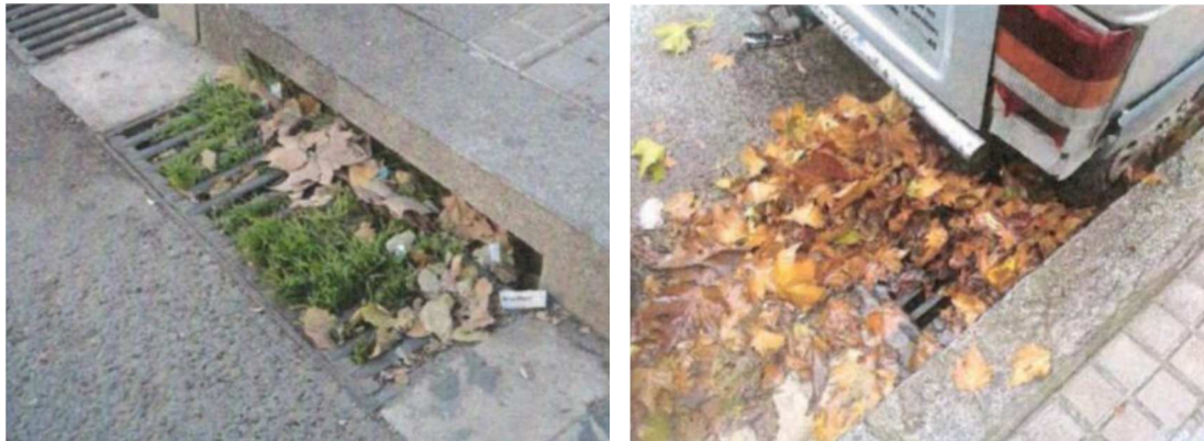
Figura 5: Imágenes de colmatación de sumideros. (Fuente: Russo B., Gómez M., 2014)
