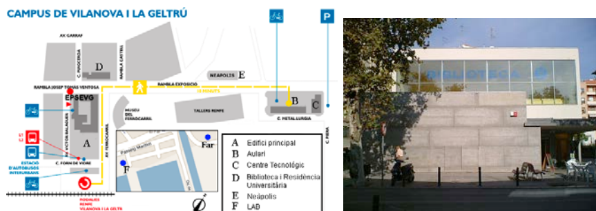
FIGURA 1 MAPA DEL CAMPUS UPC VILANOVA I FAÇANA DE L'EDIFICI DE LA BIBLIOTECA
