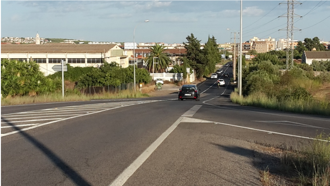
Il·lustració 12: Carretera BV-2115 a la altura del PK 1 (Fuente: Propia)
