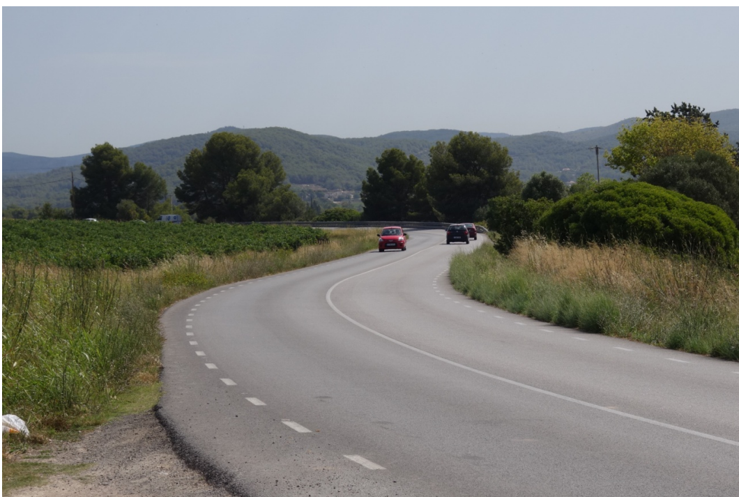
Ilustración 10: Carretera BV-2113 a la altura del PK 2 (Fuente: Propia)
