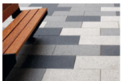
Paviment de lloses de formigó Per a les places
