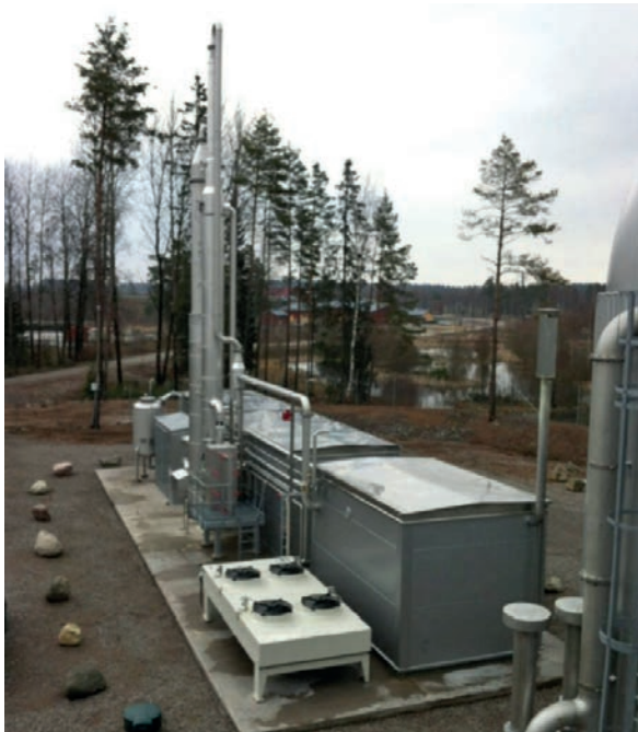
Figura 8.6. Planta para la producción de biometano usando la técnica de lavado en monoethanolaminas (MEA). Cortesía de Purac Puregas
