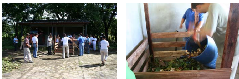
Figura 2. Construcción del compostador.
