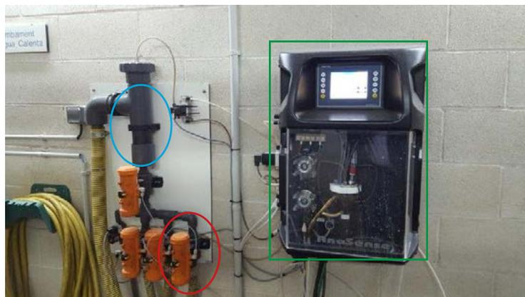
Figura 9. Analizador en línea de AGV y ALK ANASENSE TITRILYZER de Applitek (verde), filtro metálico de 1 mm con limpieza por aire comprimido y agua (azul) y válvulas neumáticas para permutar origen de muestra de Digestión 1 a Digestión 2 y etapas de limpieza (rojo)
