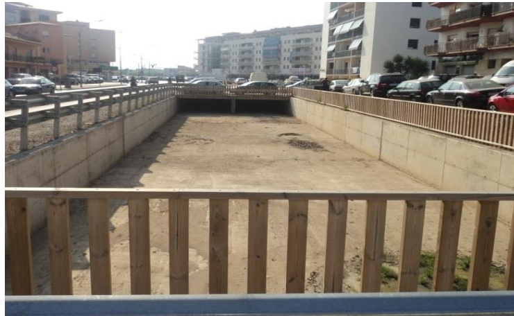
Figura 3: Vista de la situació actual
