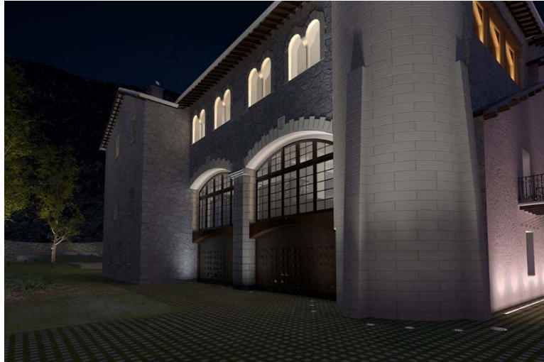
Vista 21. de la façana des de l'accés per l'ascensor
