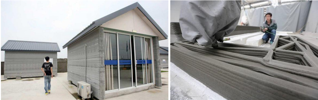
Exemples de les construccions impreses de la companyia Winsun
