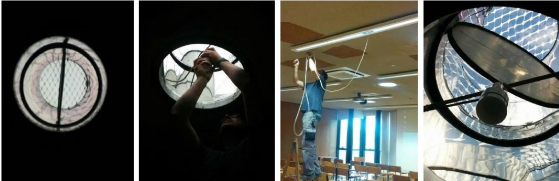
Foto 21. Montaje de las bombillas LIFX dentro de los conductos solares.
