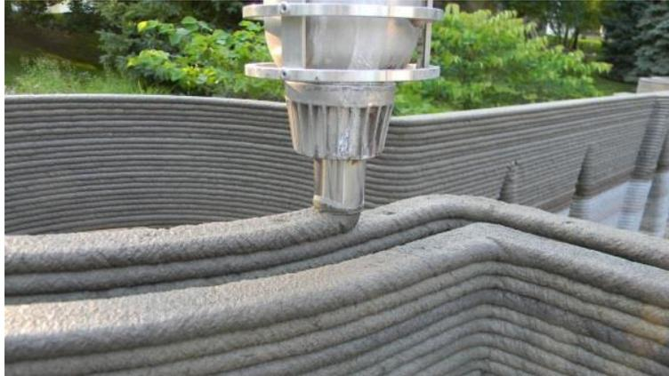
*Figura 21: Extrusora de hormigón depositándolo por capas.*
