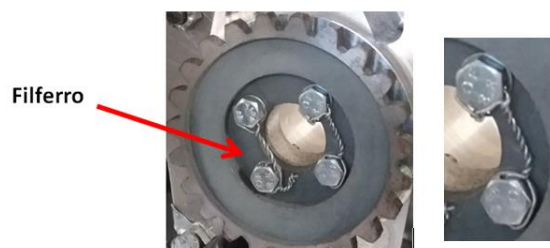
Figura 6.16 – Filferro fent de safety wiring als cargols de la roda del sensor
