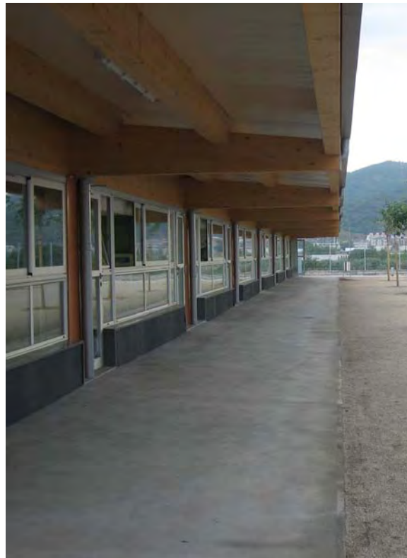
COBERTES INCLINADES AMB ESTRUCTURA DE FUSTA A LES AULES INFANTILS I EL GIMNÀS
