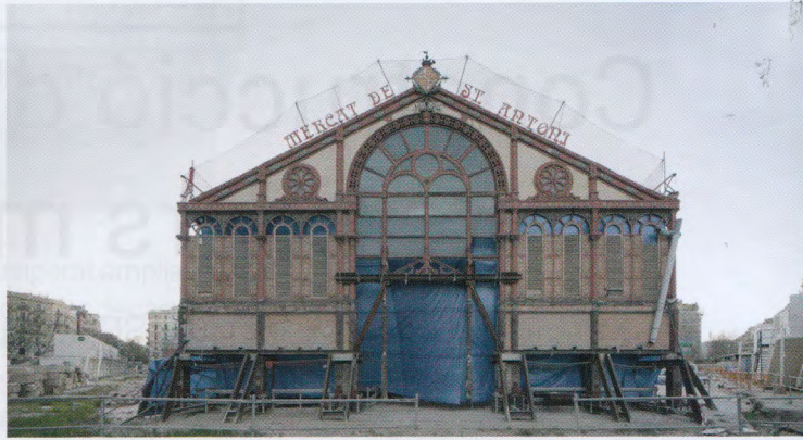
La reforma del Mercat de Sant Antoni ha fet ús de geotèrmita
