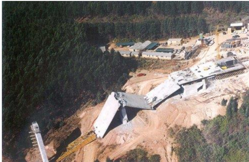
Figura 1. Col·lapse Pont Injaka
