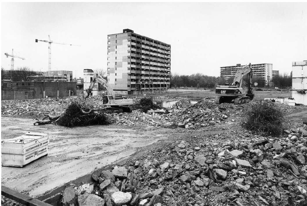
Figura 3 | Demolizione dei blocchi di Bijlmermeer, 1998. Fonte: Bijlmermuseum.
