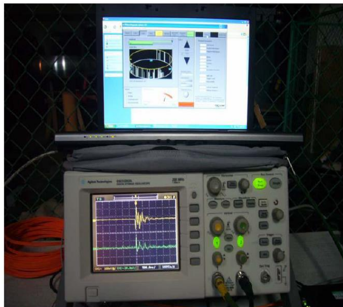
Figura 8: Detección eléctrica y acústica de DP.
