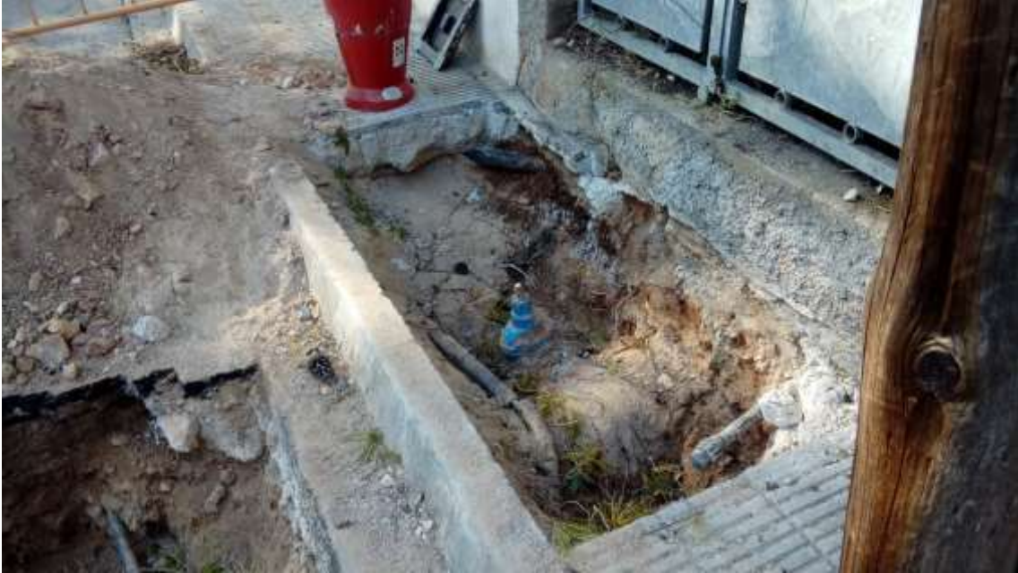
Figura 9.2. Zanja realizada cerca del depósito Collado. [Fuente: propia]
