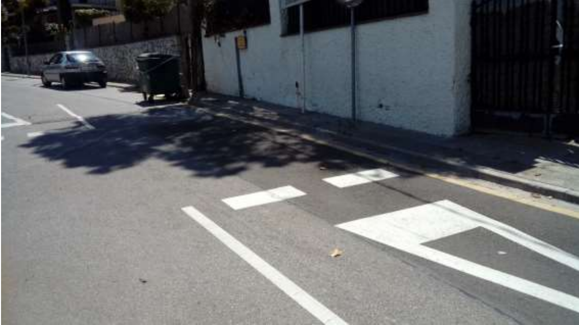
Figura 9.5. Reasfaltado de la calle Can Xum con Manel de Reguera. [Fuente: propia]
