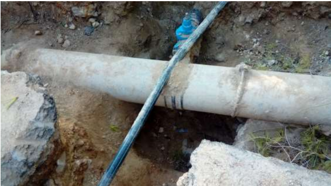
Figura 9.3. Zanja realizada cerca del depósito Collado. [Fuente: propia]
