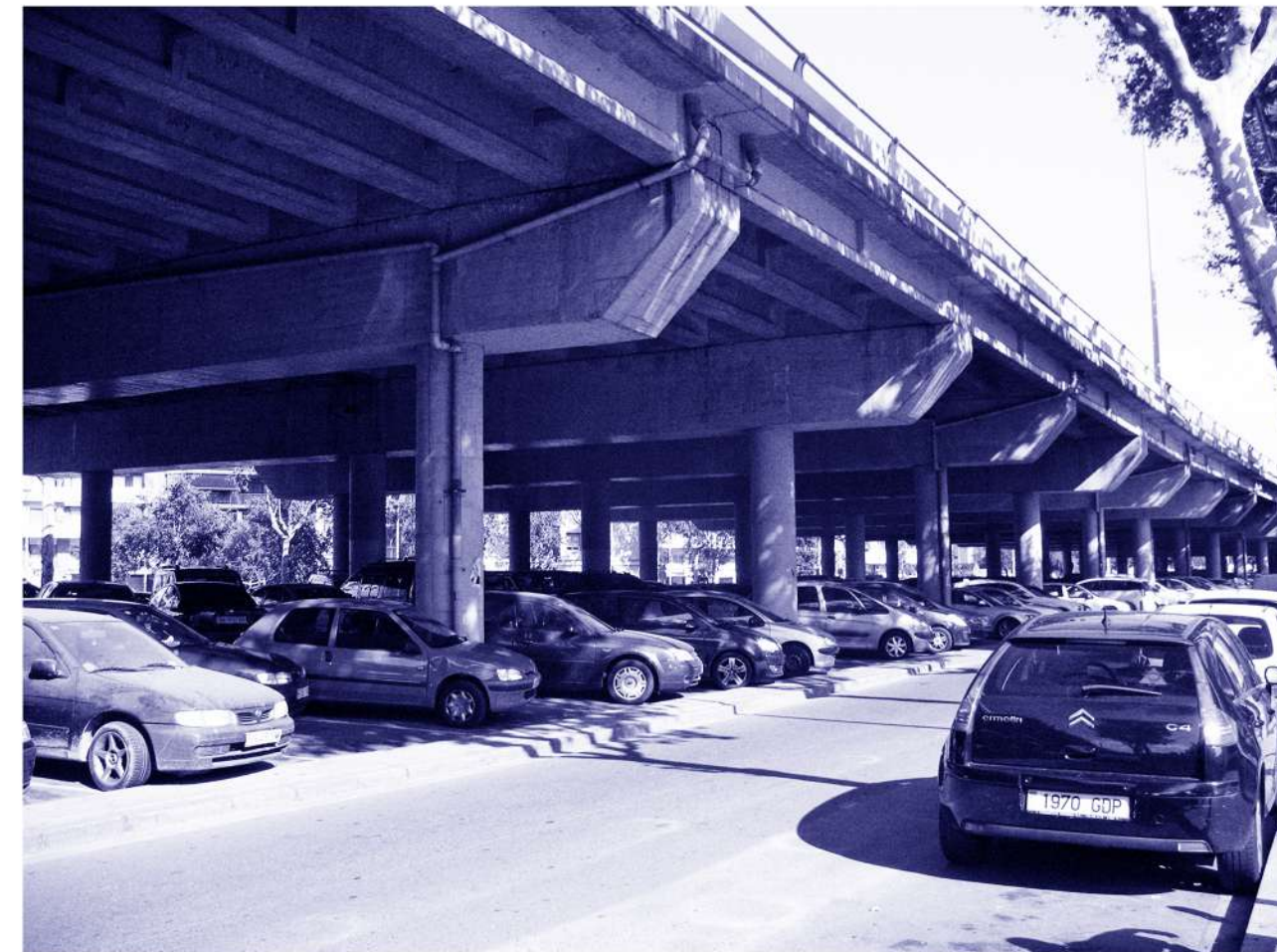
estat actual de la C-31
