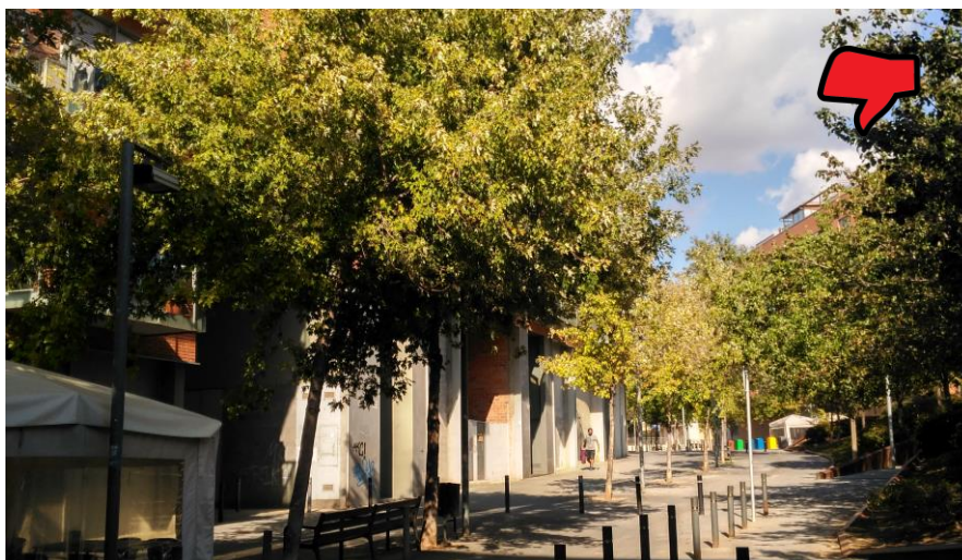
La distribució de pilones finalitza en el garatge de l'habitatge, impedit l'accés a la resta d'edificacions que es troben al llarg del carrer.
