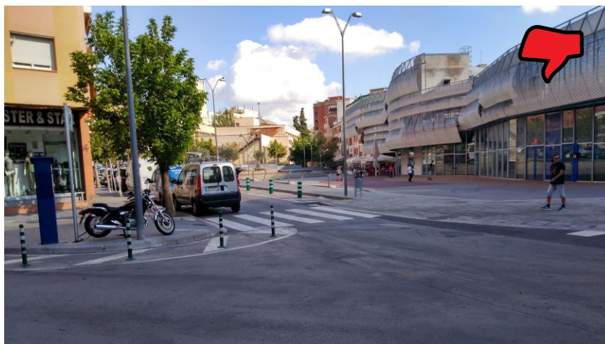
La instal·lació de pilones en la calçada en la zona de gir dels vehicles, i posteriorment espai de maniobra.
