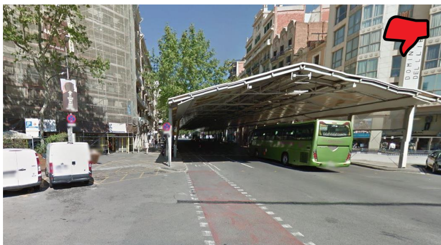
Instal·lació d'una estructura provisional mentre duren les obres de reforma del mercat municipal que dificulta la intervenció amb autoescala, tot i que lateralment es preveu un petit espai per a accés dels vehicles d'emergència.
