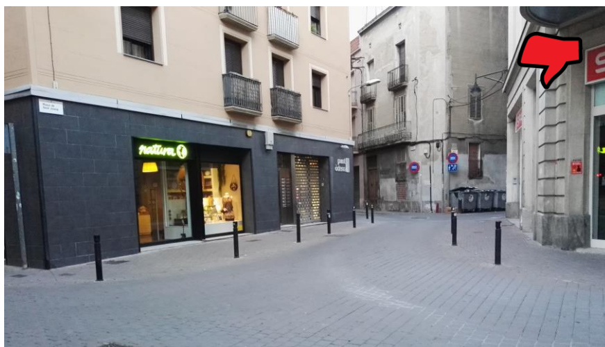
Instal·lació de pilones i contenidors que dificulten la maniobra dels vehicles d'emergència en el tram més estret del carrer.
