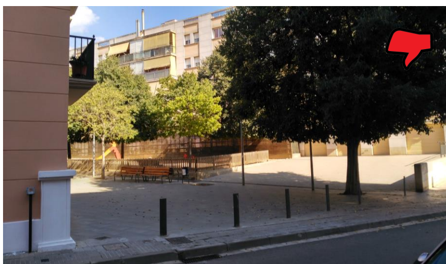
Instal·lació de pilones en un parc amb edificacions en alçada que tenen un pati davanter.
