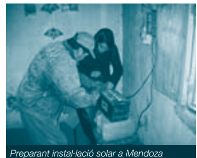
Preparant instal·lació solar a Mendoza
