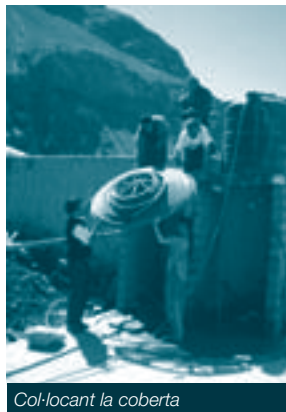
Col·locant la coberta
