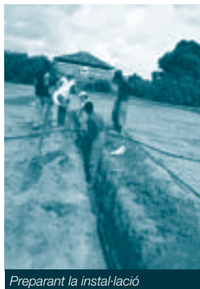
Preparant la instal·lació
