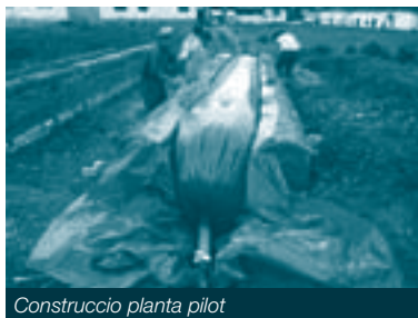
Construcció planta pilot
