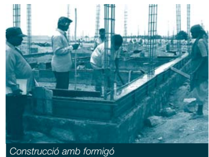
Construcció amb formigó
