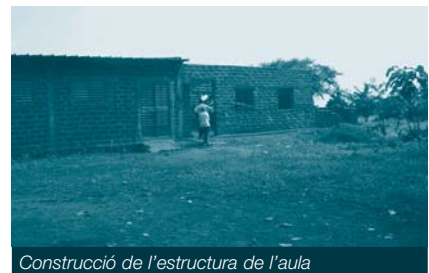
Construcció de l'estructura de l'aula
