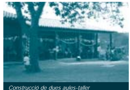
Construcció de dues aules-taller
