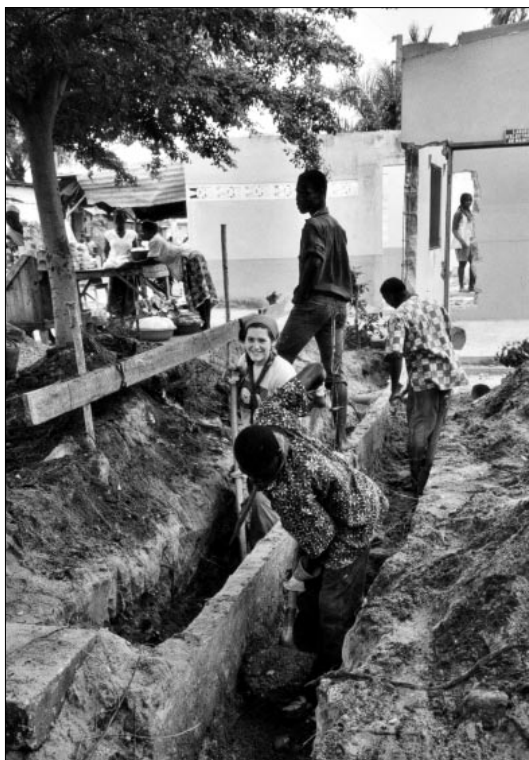
• Treballs de construcció en el centre de formació a Cotonou
