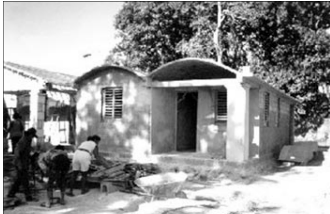
• Una de les construccions realitzades a Cuba
