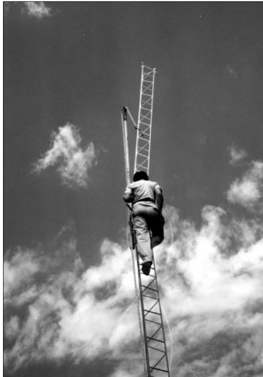
• Instal·lació de la primera torre a Tintina
