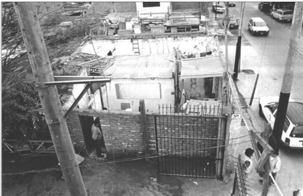
• Estat inicial dels habitatges
