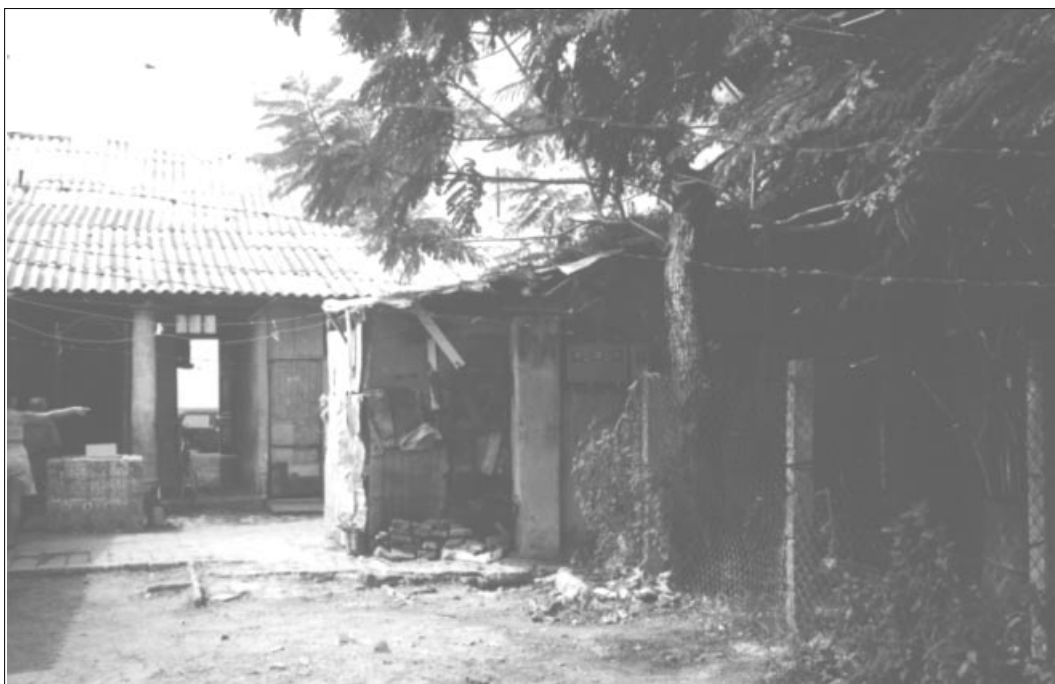
• Estat de les cuarterías
