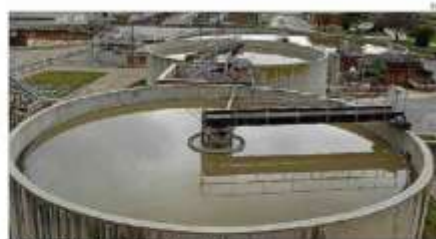
Imatge de l'estació depuradora de Manresa
