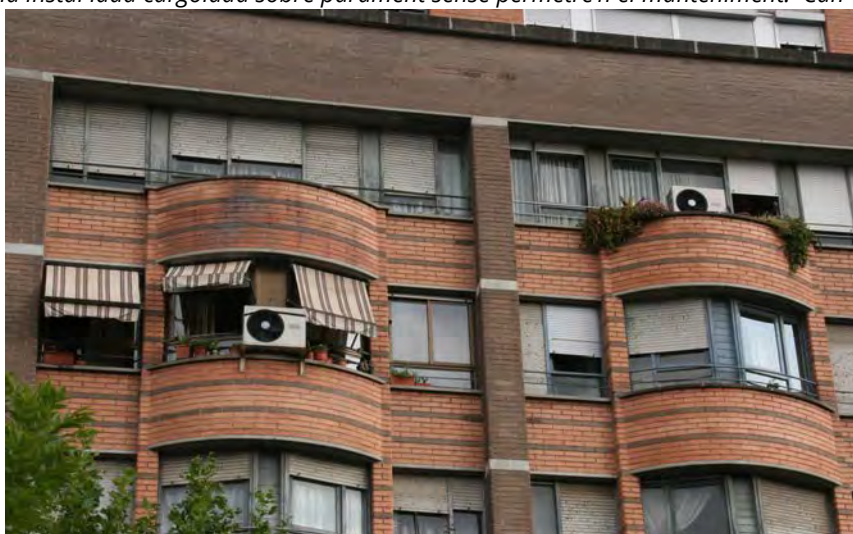
Figura 75.- Llevant Sud. Substitució de fusteria original, persiana i afegit de toldos.
