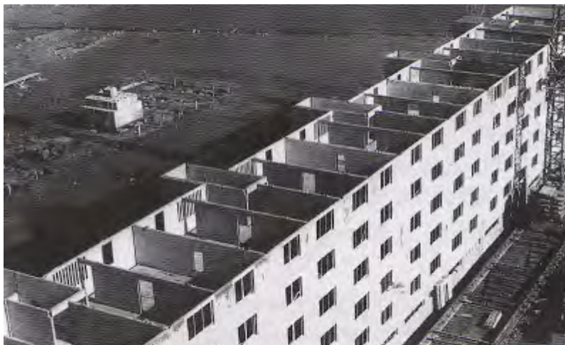
Figura 61.- Construcció Polígon Bellvitge amb panells de formigó prefabricats. Any 1965.
