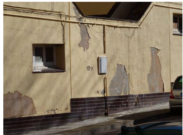
Figura 27.- Taques, escrostats i eflorescències a la zona sòcol de les promocions d'Abdera.
