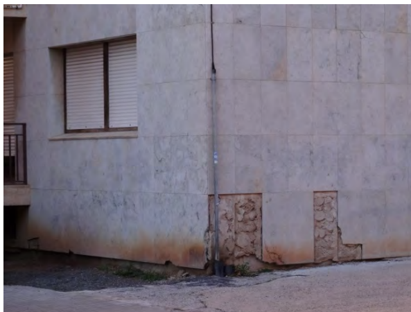
Figura 26. - Taques i desprendiments en zones en contacte amb el terreny de la promoció Olesa i
