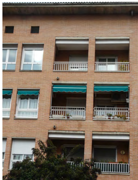
Figura 72.- Barana metàl·lica sobre sòcol d'obra amb escopidor. Tres Torres I. Granollers.
