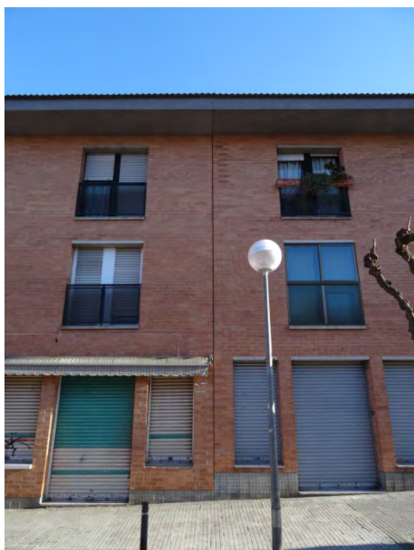
Figura 71.- Balconeres amb barana. Can Canals, Sant Andreu de la Barca
