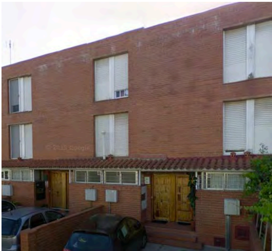
Figura 86.- Ventilació de calderes de cuines en galeria per tub en coberta sense ventinació a quatre vents.
