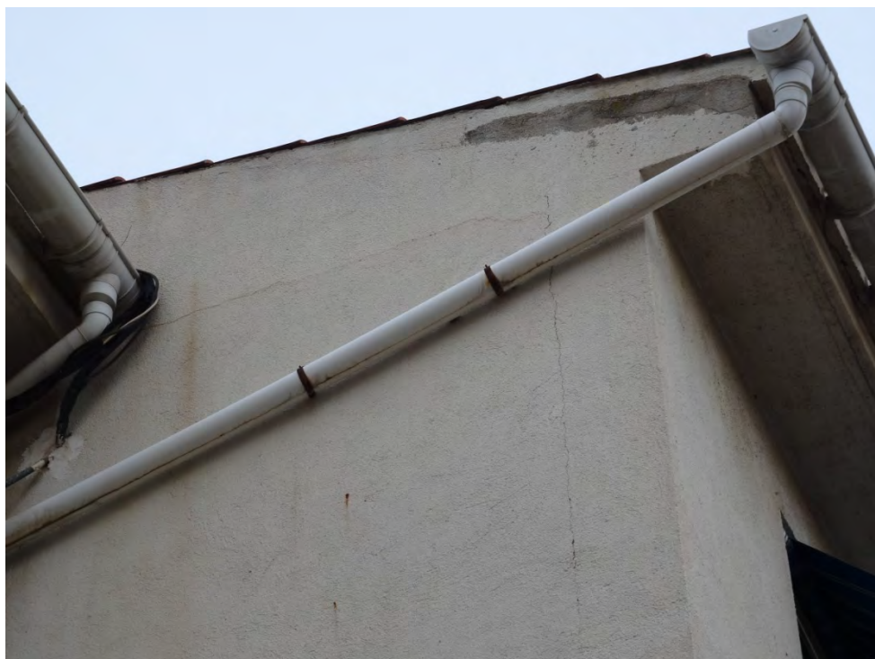
Figura 79.- Canaló perimetral en PVC i baixants en façana. Santa Coloma I, Santa Coloma de Gramenet.
