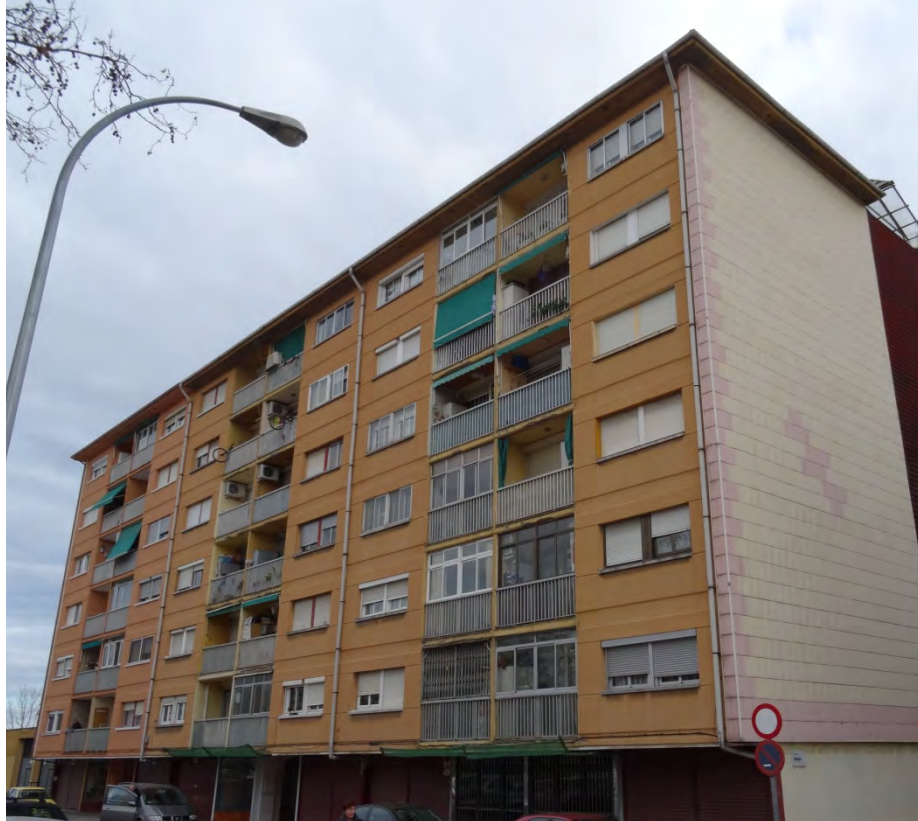
Figura 63.- Tancaments de Terrassa en alumini, duts a terme pels propietaris en el transcurs dels anys. El Prat 2. El Prat de Llobregat
