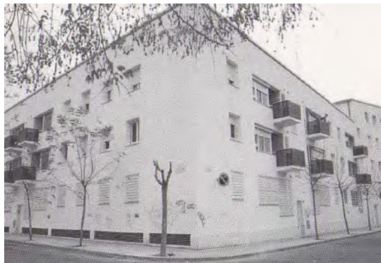
Figura 17.- Edifici al c/Bujaruelo, Sabadell. Aparcament en planta semisoterrani.
