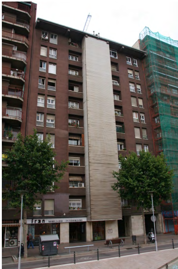
Figura 62.- Edifici a la Gran Via, promoció Gelida, Barcelona. Amb façana amb balcons mínims reculats de façana i els únics elements sobresortints són els ràfecs i la tribuna dels safareigs.
