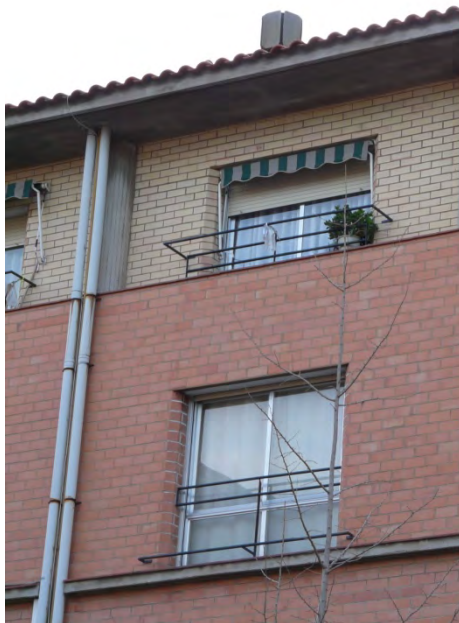
Figura 69.- Balconeres a dues altures amb protecció metàl·lica. Gallecs 1, Mollet del Vallès.
