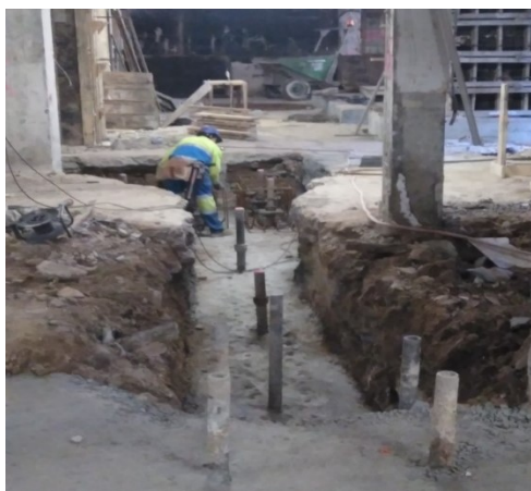
Figura 5-21: Fase de introducción de la primera capa de hormigón
