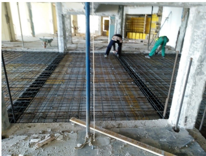
Figura 5-29: Piezas de hormigón en forma de piedras que cubren la superficie de madera y sobre éstas, puede verse el emparrillado
