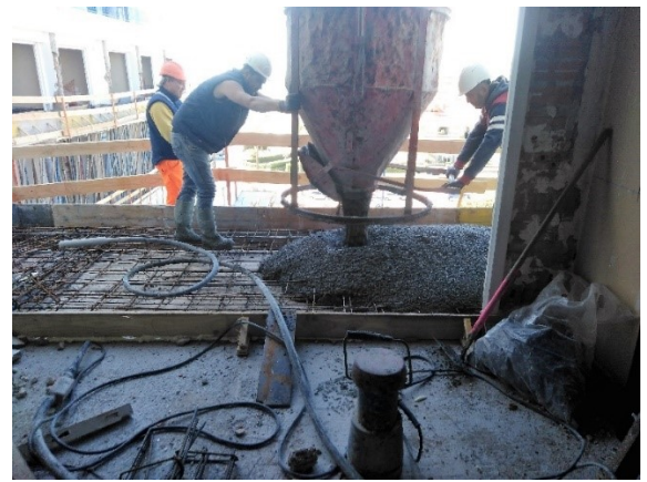
Figura 5-55: Colocación del hormigón con el barril
