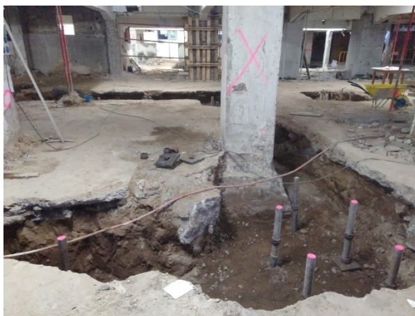
Figura 5-20: Micropilotes
