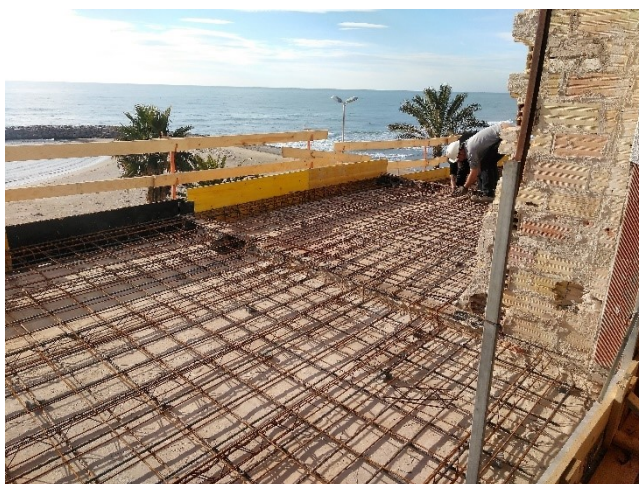
Figura 5-52: Conjunto de emparrillado, celosía y mallazo
