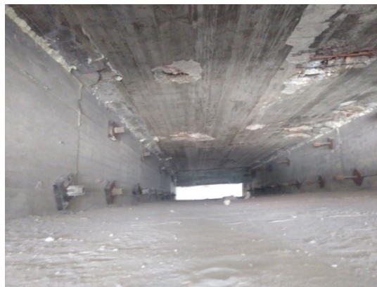
Figura 5-18: Jácenas hormigonadas con los topes de las barras de tesado en el exterior
