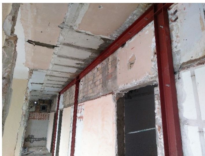
Figura 5-70: Acabado de los apeos en los pasillos
