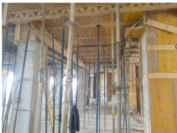
Figura 5-27: Puntales vistos desde abajo
