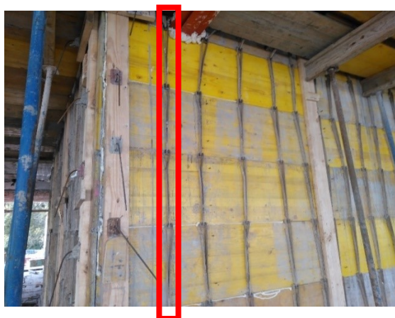
Figura 5-23: El rectángulo rojo muestra las corbatas colocadas sobre la tabla de madera
