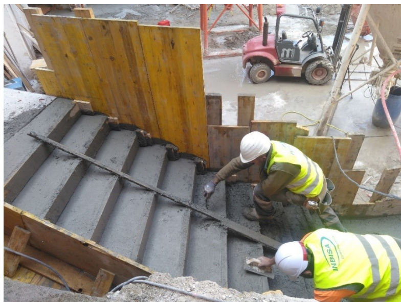
Figura 5-34: Aplanamiento de los escalones
