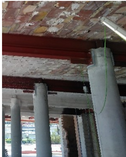
Figura 5-84: Perfil IPE soldado a uno de los pilares
