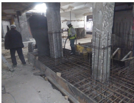
Figura 5-6: Inserción del hormigón y aplicación simultánea del vibrador
