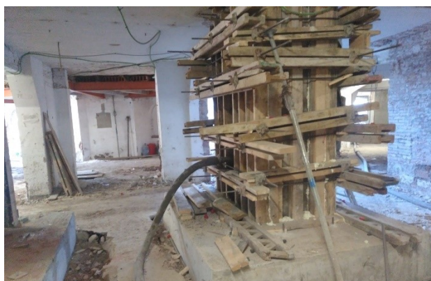
Figura 5-9: Inserción del hormigonado a presión por medio de una manguera
