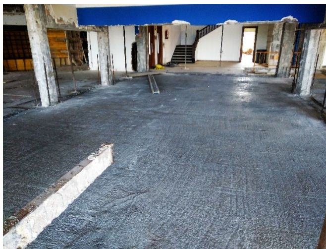
Figura 5-31: Hormigonado del suelo para la obtención del nuevo forjado
