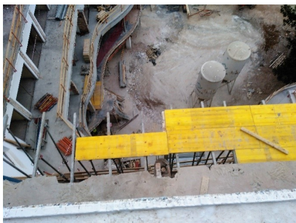
Figura 5-46: Colocación de tablas de madera sobre las viguetas
