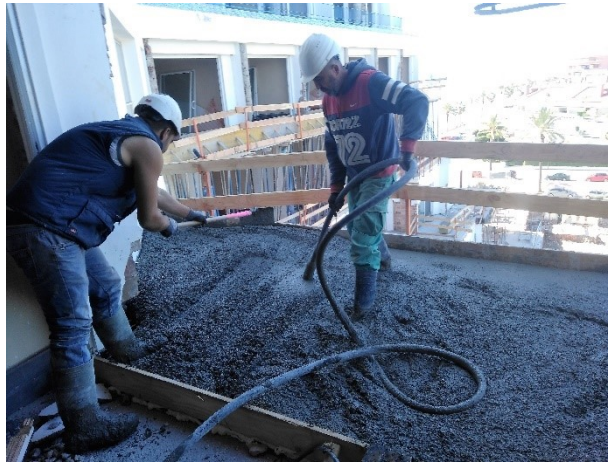
Figura 5-56: Aplicación del vibrador y nivelación de la superficie
