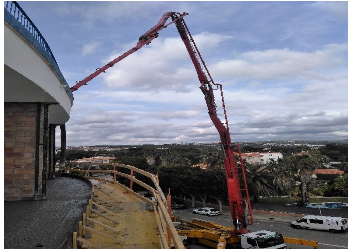
Figura 5-53: Inserción del hormigón mediante la grúa de hormigonado
