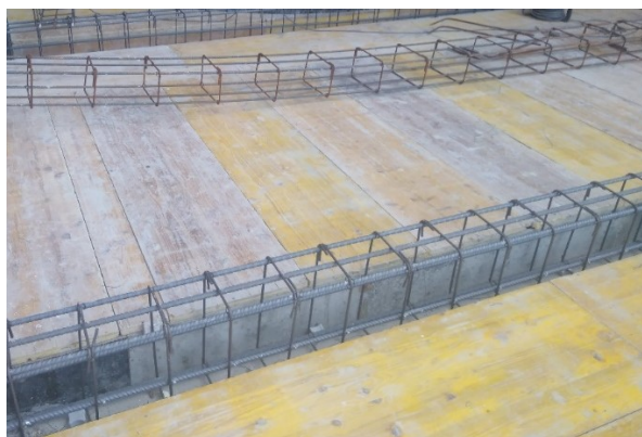
Figura 5-30: Armadura de la jácena
