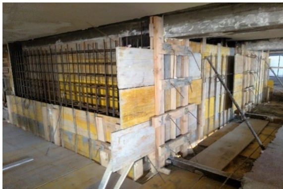
Figura 5-25: Encofrado
