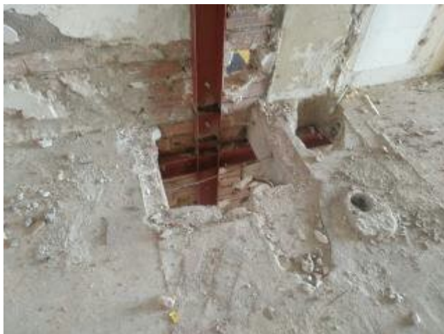
Figura 5-66: Unión de 4 perfiles
