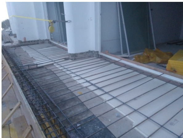
Figura 5-51: Placas de material liviano para ganar altura
