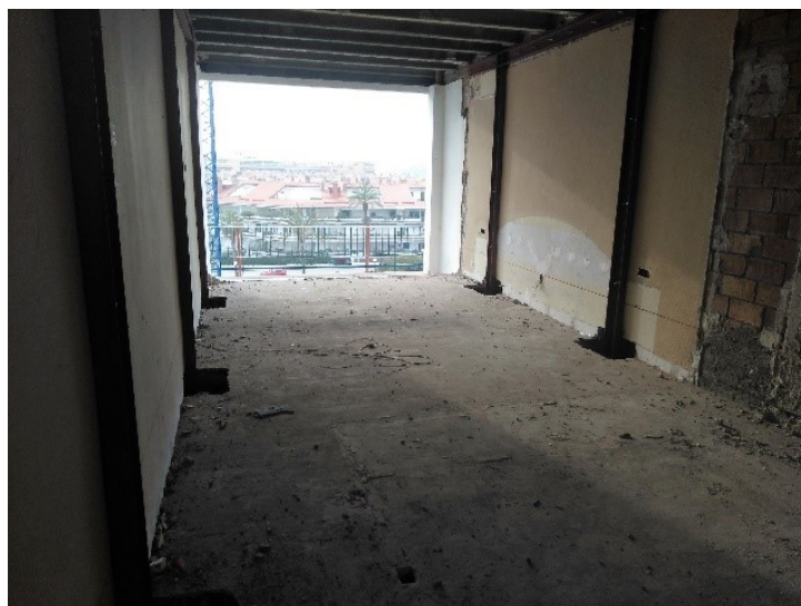
Figura 5-69: Acabado de los apeos en una de las habitaciones
