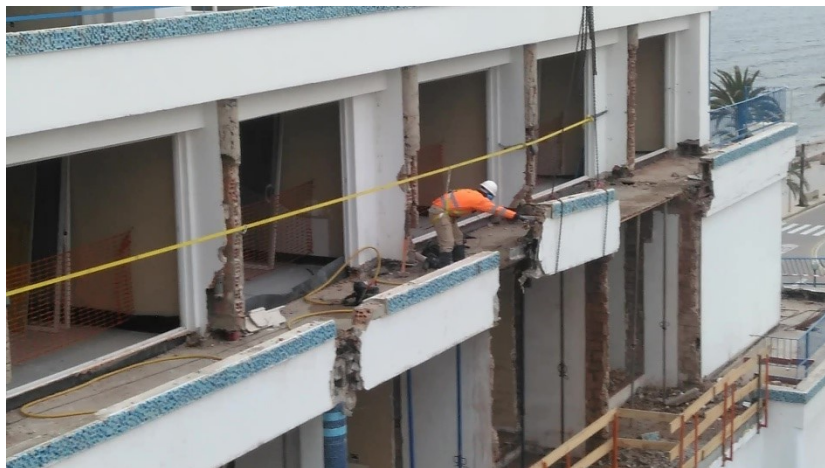
Figura 5-42: Retiro de la misma
