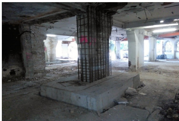
Figura 5-8: Encepado y armadura que refuerzan el pilar
