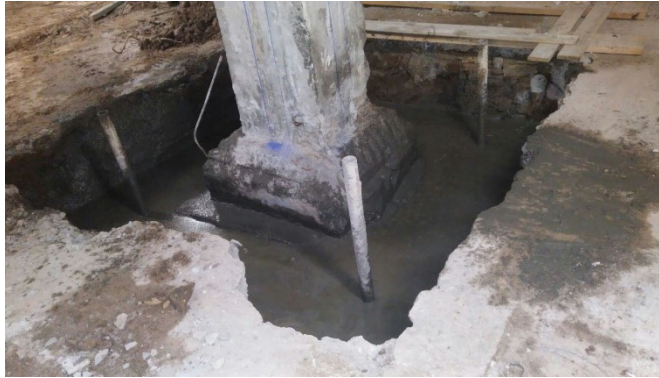
Figura 5-2: Micropilote de la obra
