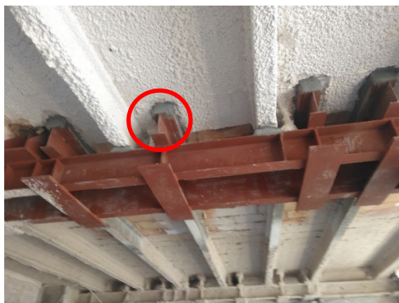
Figura 5-87: Perfiles IPE cortos de refuerzo
