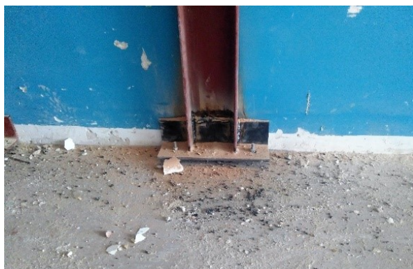
Figura 5-67: Placa con pernos niveladores
