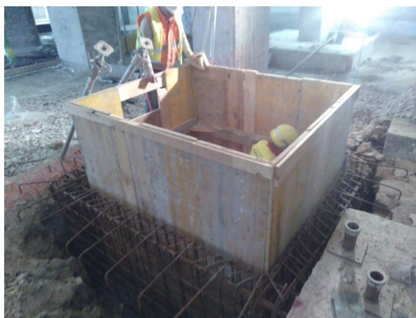
Figura 5-58: Armadura del foso
