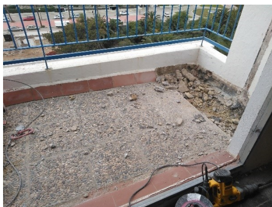
Figura 5-40: Demolición del suelo de la terraza
