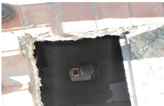
Figura 5-78: Conjunto de agujeros visto desde la planta superior
