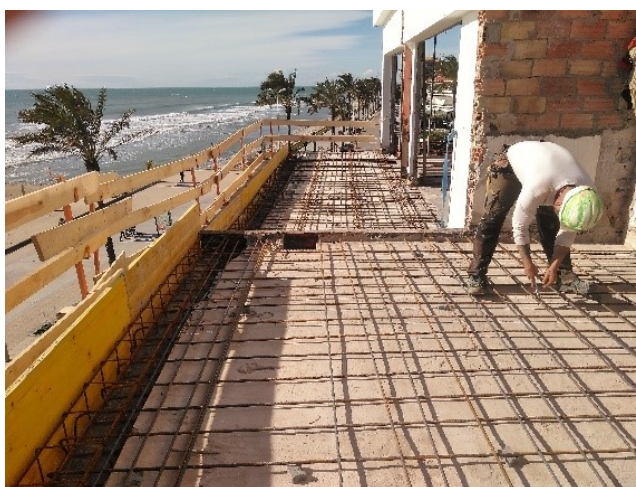
Figura 5-50: Colocación del emparrillado
