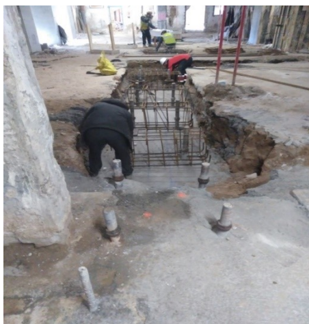
Figura 5-22: Instalación de la armadura
