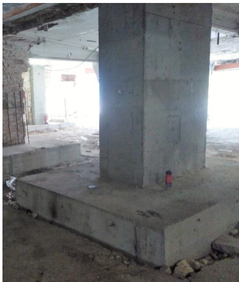
Figura 5-10: Resultado final del pilar reforzado
