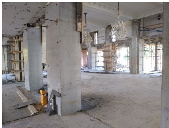
Figura 5-11: Pilares de planta baja acabados y algunos encofrados al fondo
