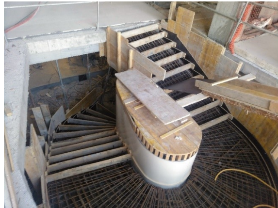
Figura 5-38: Encofrado de escalones
