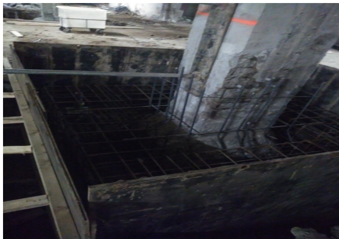
Figura 5-5: Tablas de encofrado
