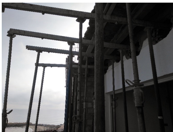
Figura 5-45: Apuntalamiento de vigas
