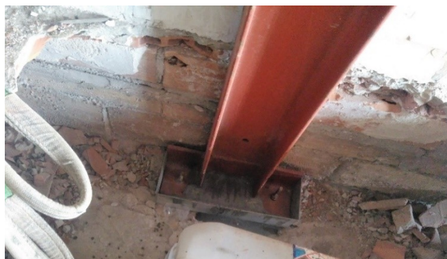
Figura 5-68: Placa nivelada y encofrada
