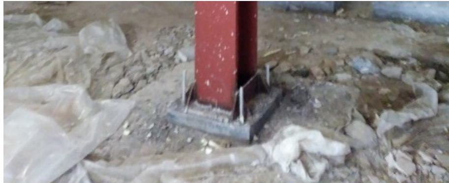
Figura 5-73: Mortero autonivelante entre la placa base y el suelo
