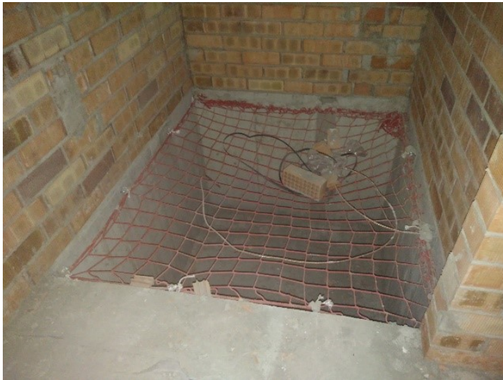
Figura 5-60: Foso del montacargas de la cocina
