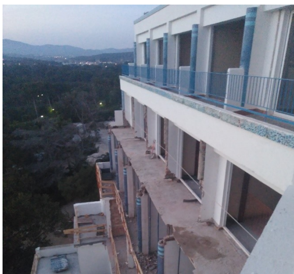
Figura 5-44: Imagen del edificio sin las terrazas
