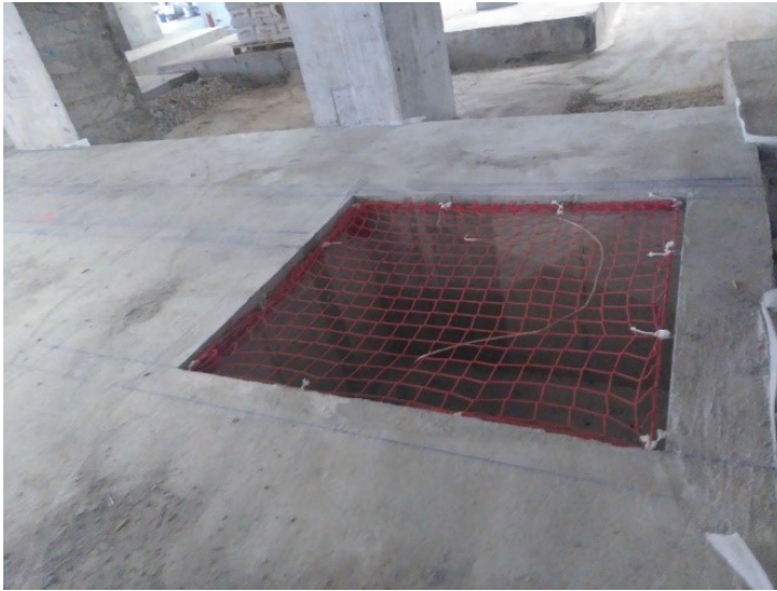
Figura 5-59: Foso del montacargas principal
