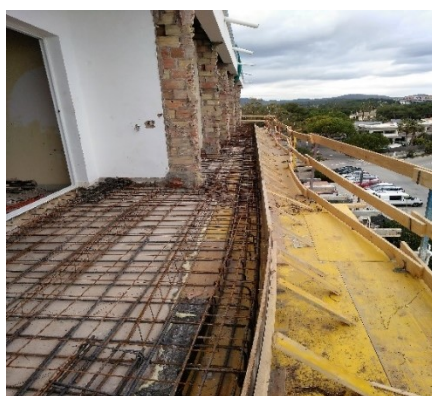
Figura 5-49: Vista de la terraza armada con su respectiva zona de trabajo
