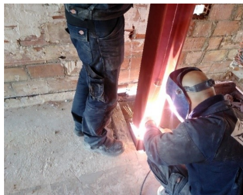
Figura 5-79: Soldadura de 2 pilares
