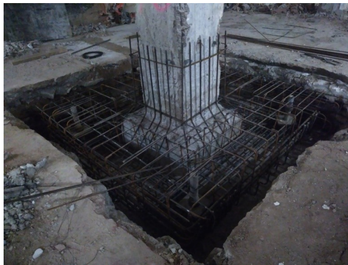
Figura 5-3: Armadura de un encepado
