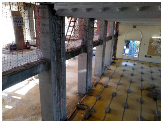
Figura 5-13: Acabado del refuerzo de pilares de la planta baja y primera planta
