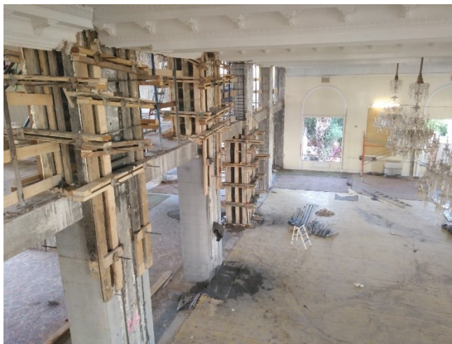
Figura 5-12: Encofrados planta baja y primera planta
