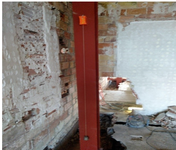
Figura 5-65: Ejemplo de la prueba del plomo
