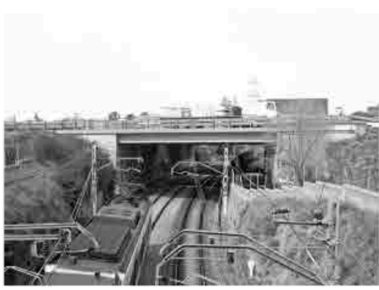
Passatge Pas per sota l'Autopista amb accés per a vianants
