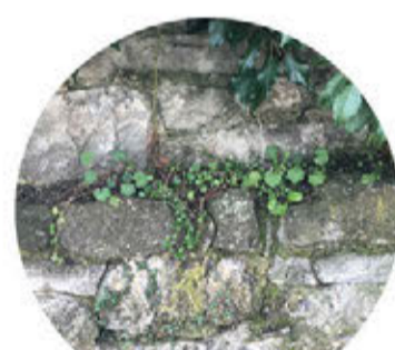
Creixement d'herba invasiva en el parament. Risc de que es desenvolupi i mamenti el mur.
