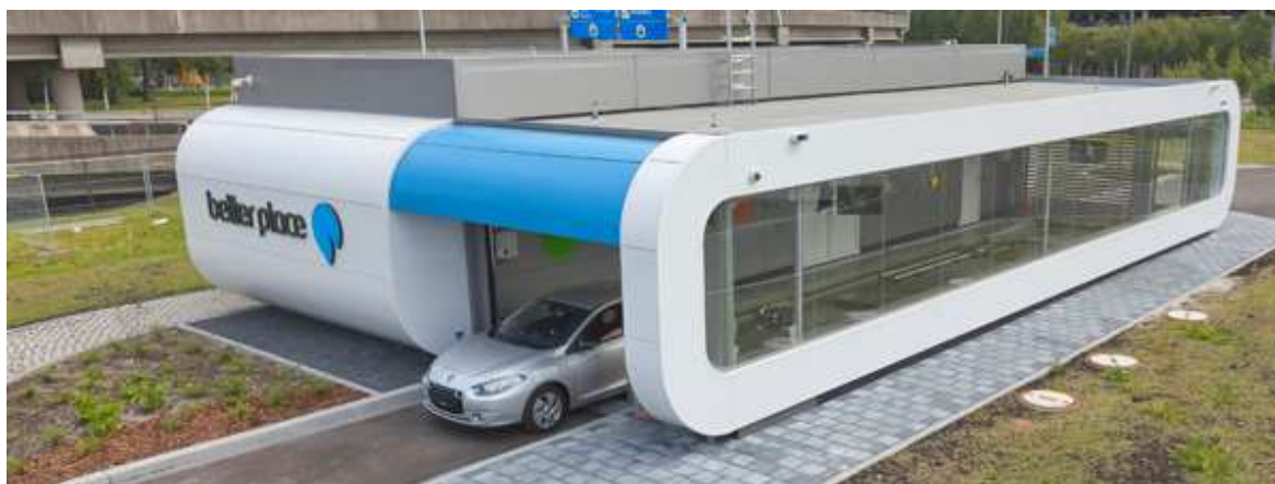
IL·LUSTRACIÓ 10: ESTACIÓ DE CANVI RÀPID DE BATERIA PER COTXES DE LA COMPANYIA BETTER PLACE
