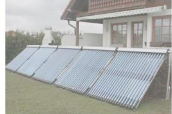
Panel·s solars per producció d'ACS - CCEnèrgia Aconsegueixen temperatures des de 50 a 100 °C, de còdure i "heat pipe". Compleixen amb la Norma Ambiental NADP-008-AMBT-2005
