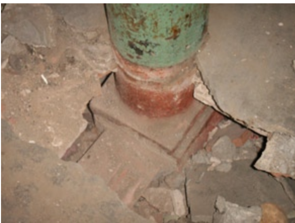
NUS ESTRUCTURAL I FAÇANA DE LA NAU DE LA FÀBRICA BERTRAN
