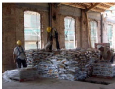
6. PROCÉS DE PROVA DE CÀRREGA DE LA VOLTA
