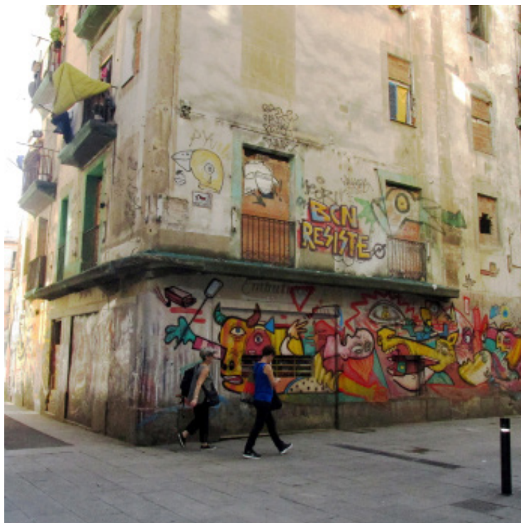
Edificio en ruinas ocupado. Carrer de l'Arc del Teatre, El Raval - Ciutat Vella.
