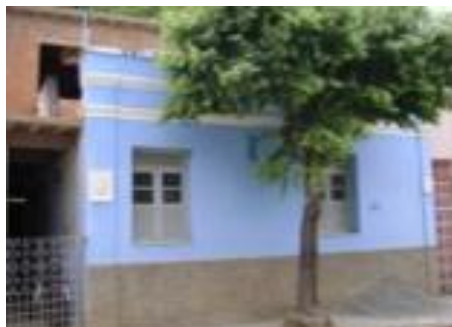
Figura 08: Edificação de um pavimento com duas aberturas de janela na fachada principal, com afastamento lateral, onde há inserção de um portão. Uma platibanda simples e retangular coroa a fachada do imóvel e é marcada pela presença de um friso horizontal. Marcação de colunas nas laterais do imóvel. Barramento com acabamento em chapisco. Inserção de novo volume que rompe com a tipologia arquitetônica e descaracteriza o imóvel histórico.
