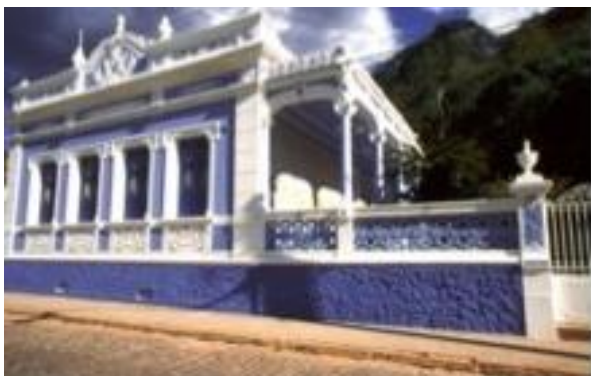
Figura 13: Casario histórico preservado. Nota-se que a tipologia do edifício, com quintal e varanda lateral, remete a ocupação do século XIX no Brasil. Rico exemplar do Ciclo do Café. Fonte: imagem – acervo da autora
