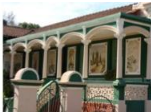
Figura 14: Casario histórico preservado. Imóvel com varanda com ricos painéis de azulejos pintados, típicos do local. Rico exemplar do Ciclo do Café. Fonte: imagem – acervo da autora
