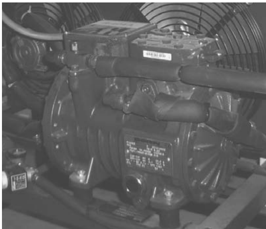
Figura 12.15. Compressor alternatiu o de pistó operant en un sistema de refrigeració d'una petita cambra de congelació.
