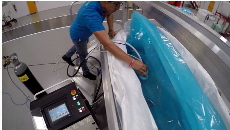
Figura 7.10. Ejecución de operaciones de vacío e inyección de gas.
